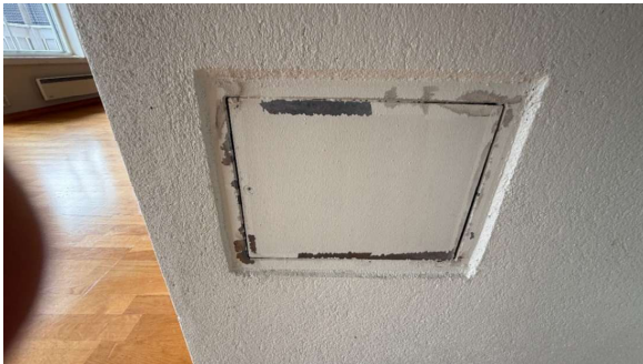
Sotluke sett utvendig
