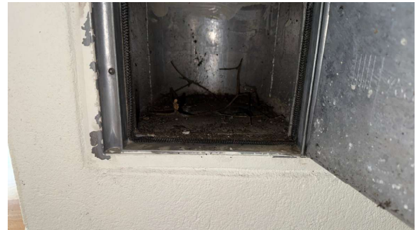
Røykrør sett gjennom sotluke.
