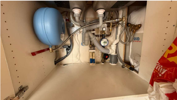
Oppvaskbenk på kjøkkenet.
